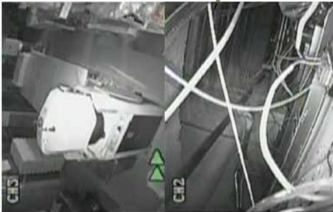
【機器作動後】※設置カメラ映像から（2009/11/7）
